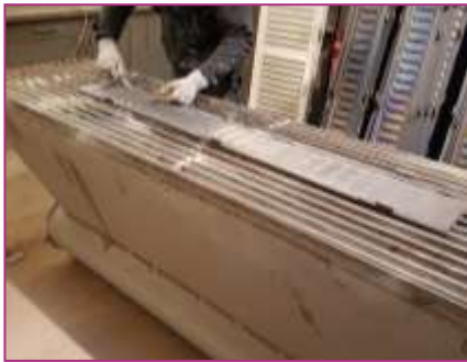
Décapage de volets en ateliers
