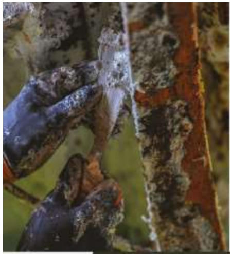
Décapage chimique d'une peinture au plomb, alternative au sablage, piquage ou grattage
