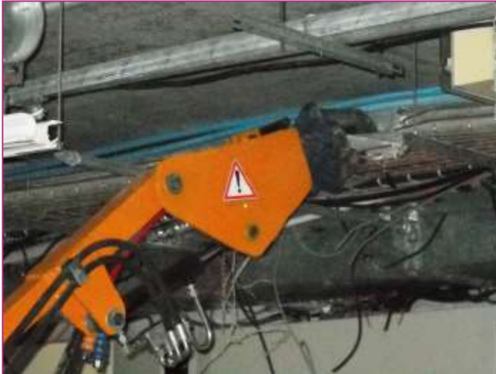
Utilisation d'une pince hydraulique, alternative à la découpe au chalumeau
