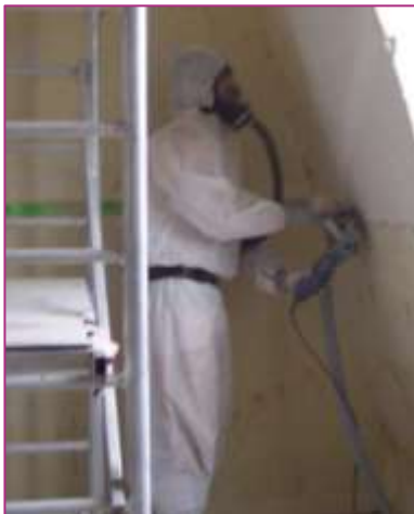
Ponçage de peinture avec une ponceuse reliée à un aspirateur de classe H selon la norme NF EN 60335-2-69
