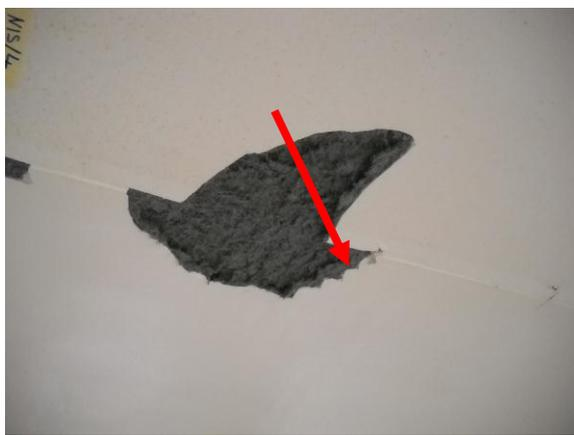
*La photo ci-contre illustre l'une des difficultés rencontrées lors du repérage des applications d'amiante. Celle-ci montre un flocage d'amiante bleu recouvrant la face inférieure d'un faux-plafond. Le flocage est totalement invisible sous une fiche couche de plafonnage.*
