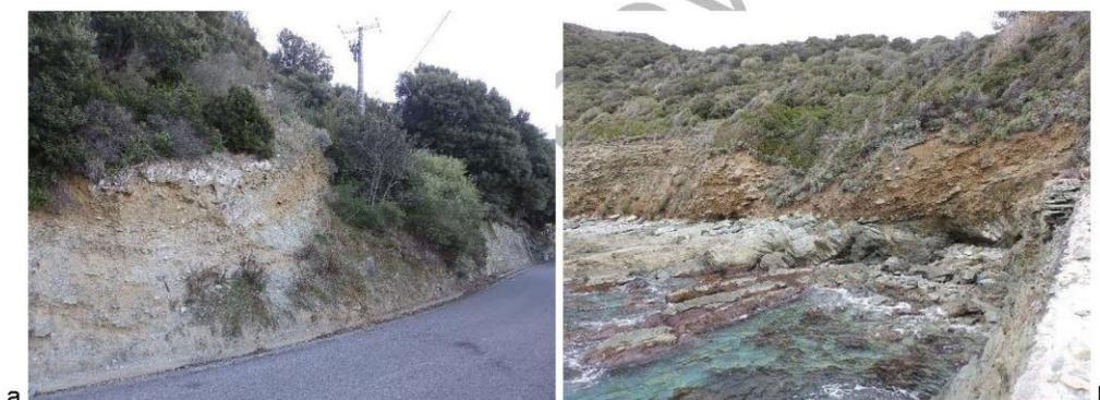
Figure 102 : Importance des colluvions observées dans le talus de la D80, à la sortie nord de Nonza (a : point 2BDL 1907) et en bord de mer, au sud de Nonza (b : point 2BDL 1894).
