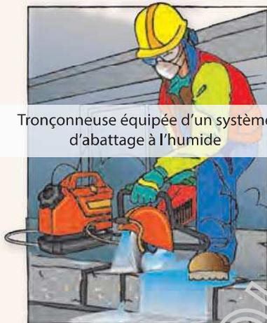
Tronçonneuse équipée d'un système d'abattage à l'humide
