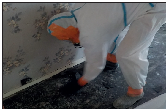
Ramassage de dalles amiantées après travaux
