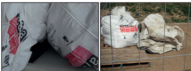
Big bag de déchets amiantés
