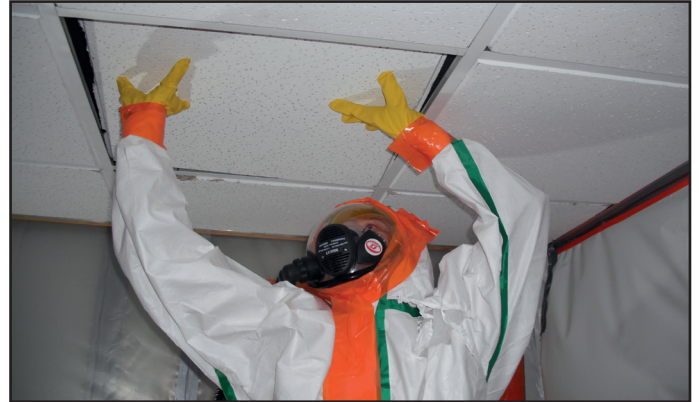
Déplacement de faux-plafond amianté pour intervention
