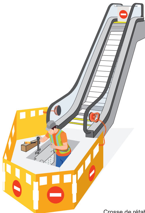
Crosse de rétablissement pour entrer dans le caisson.
