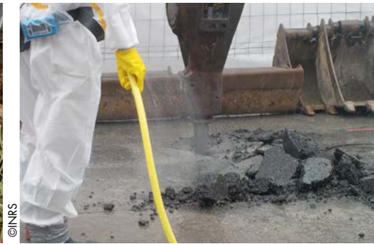
Retrait d'enrobés amiantés par burinage mécanisé et abattage des poussières par arrosage
