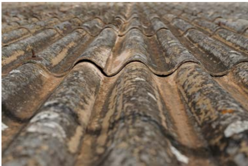
Toiture ondulée en amiante-ciment
