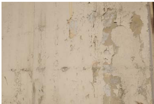
Peinture amiantée de façade extérieure
