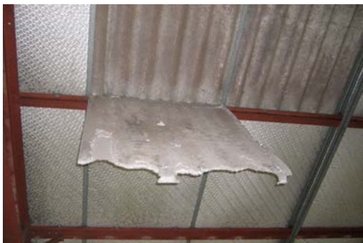
Panocell® amianté sous toiture ondulée en amiantement
