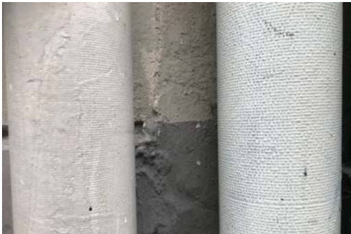
Canalisations en amiante-ciment
