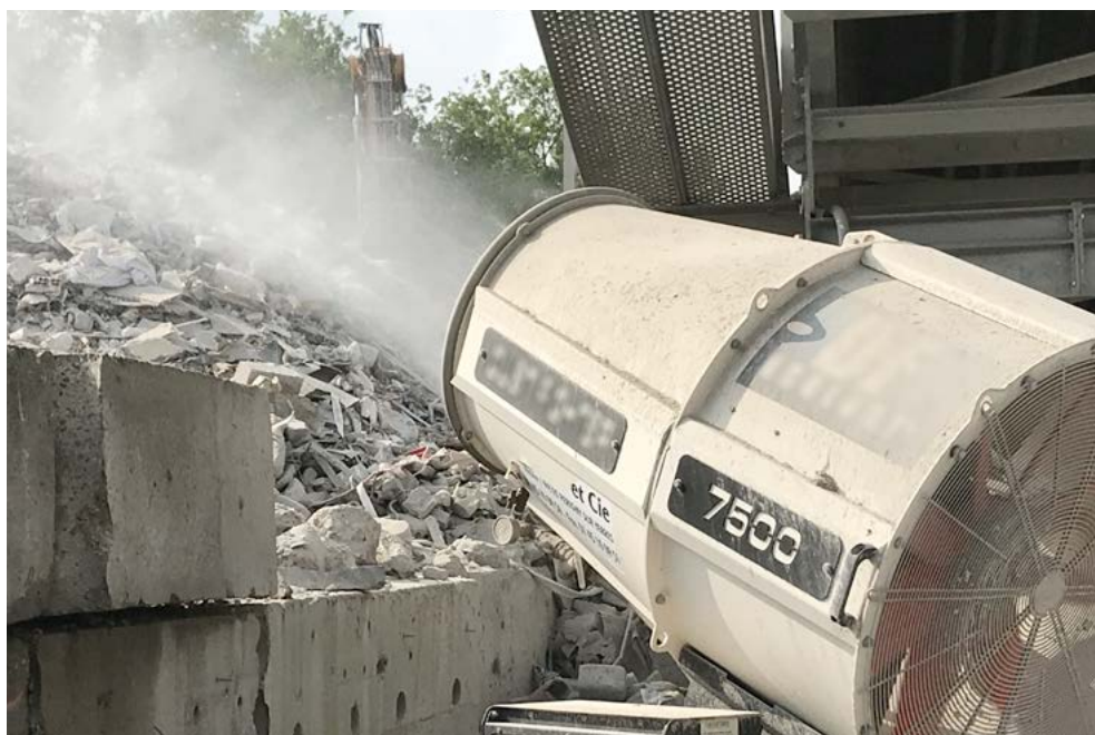
Canon à eau pour pulvérisation lors de travaux en milieu extérieur
