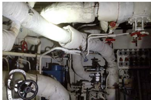
Calorifugeage amiaté
