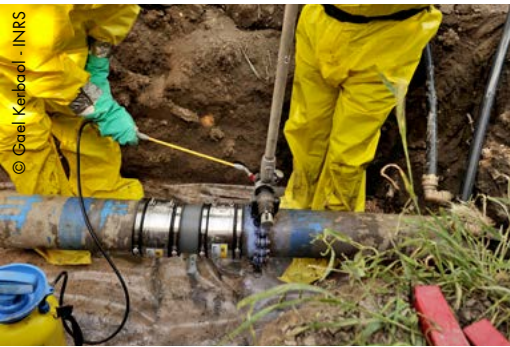
Retrait de conduit amianté au coupe-tube
