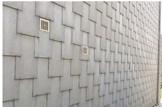
Bardage en fausses ardoises en amiante-ciment
