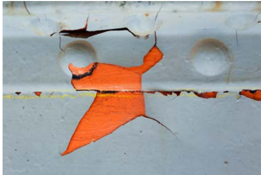
Peinture amiantée sur support métallique
