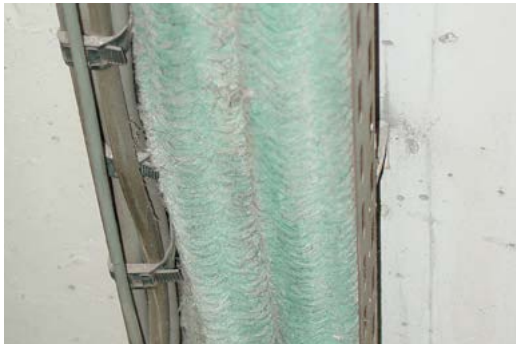
Tresses amiantées de câbles
