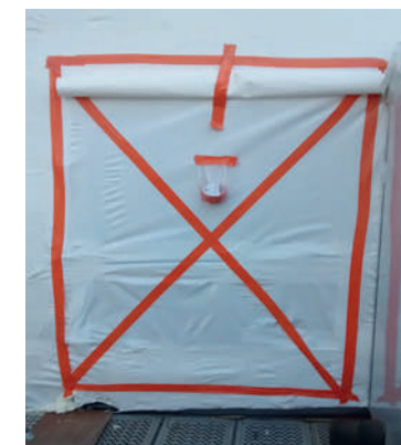
Exemple d'issue de secours
