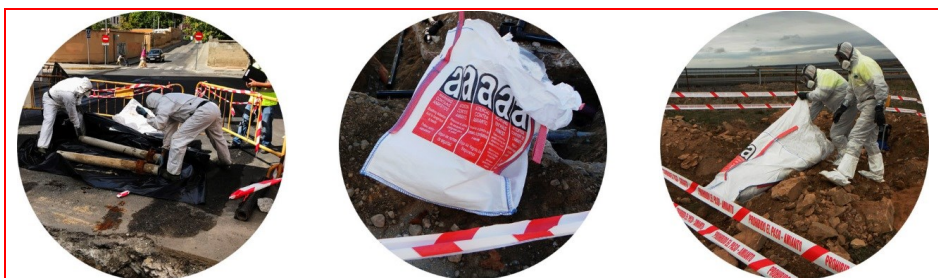
Fig. 4. Embalaje de residuos de amianto mediante bolsas de plástico posteriormente etiquetadas (izquierda); bolsas Big Bag homologadas de embalaje de residuos (centro y derecha). Fuente: Varias obras de desamiantado en la Comunidad Autónoma de Castilla y León y Madrid.
