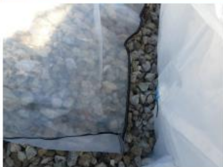
Lest béton concassé (40/80).
