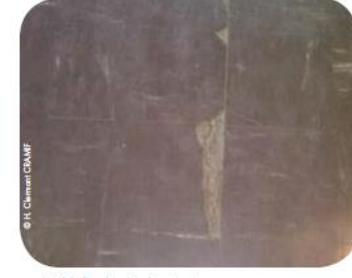
Dalles de sol en vinyle-amiante
