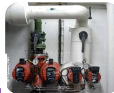
Calorifugeage de conduits
