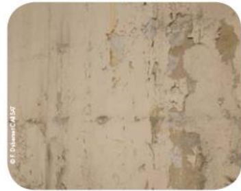
Enduit de façade
