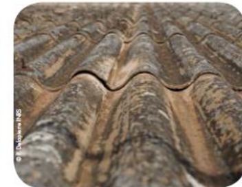
Toitures en amiante-ciment
