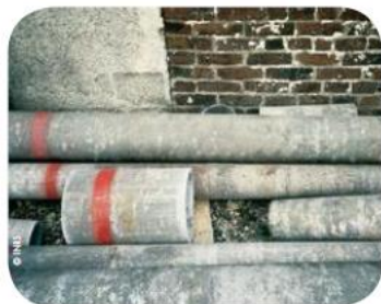
Canalisation en amiant-ciment
